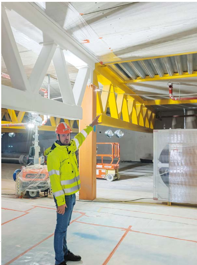
Fackverkssystem som utgör ett grund för takhusbyggandet.
