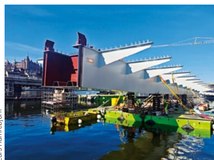
Brosektion B (36 meter lång och 91 ton) förbereds för montaget.
