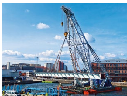
Brosektion C (51 meter lång och 124 ton) är på väg att placeras på en ponton.
