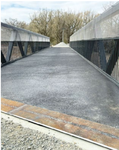
Nybyggnation av bro i Lund.
