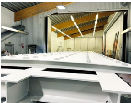
Nybyggnation av bro.
