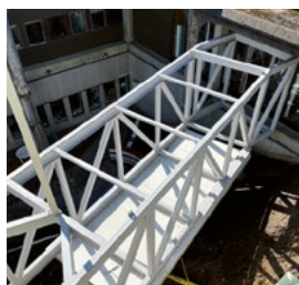
En av två gångbroar som knyter ihop nybyggnationen med lasarettet.
