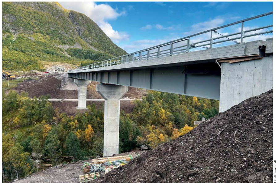
Kongsvikelubrua ved E10 Hålogalandsvegen - ferdigstøpt med montert rekkverk.
