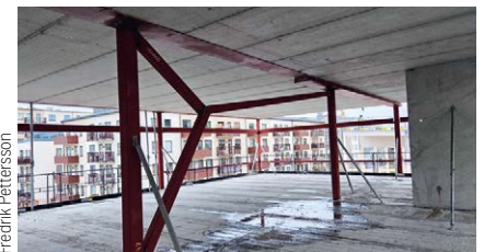
Knäckt vindstag för att skapa väggöppningar.
