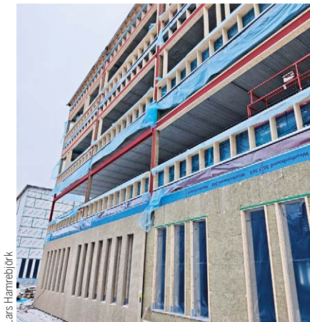
Stomme delvis inbyggd i utfackningsväggar.
