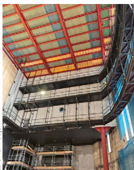
Teknikbryggor ovanför scenen på stora stålpelare.
