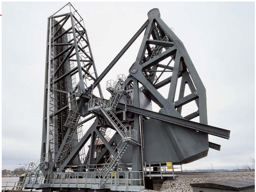
Den nya klaffbron i Vänersborg har en ytbehandling av färg med zink.
