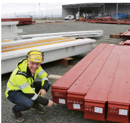
Annamaj Lasson visar några återbrukade stål balkar som har bearbetats av VSAB och väntar för montage på stommen till Grand.
