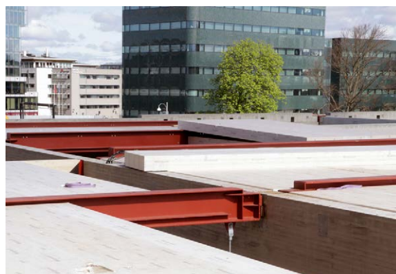
Här kan ses några av de återbrukade stål balkarna som har monterats på plats och bär KL-bjälklagen.
