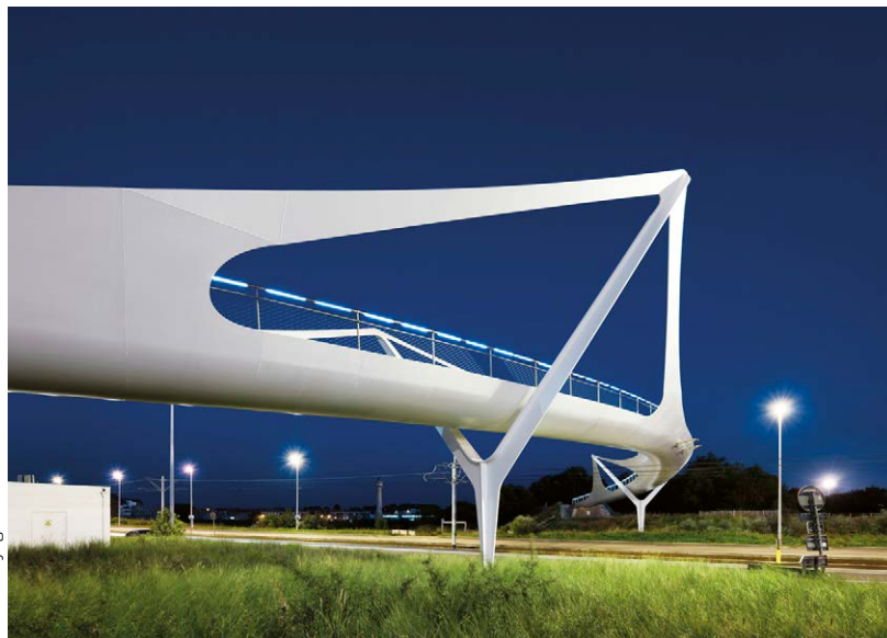
Lichtenlijn Footbridge Knokke-Heist Belgium
