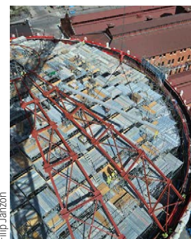
Två av 32 stycken "tartbitar" av takkonstruktionen har monterats.
