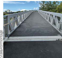
Ramp från markplan till svängen och vidare över Värmdövägen.
